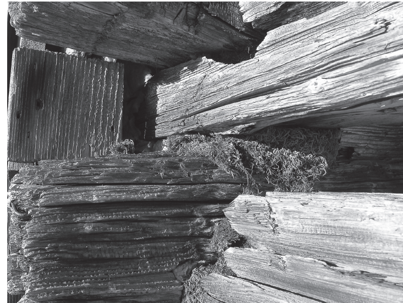
Moose als Füllmaterial zwischen den Balkenlagen eines Blockhauses
