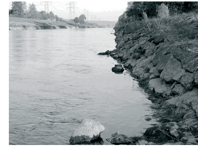
Abb. 1: Linthkanal bei Niedrigwasser am 19. Sept. 2003
